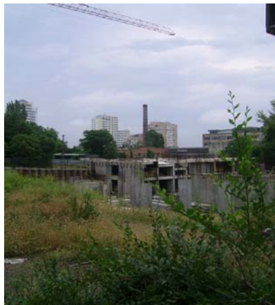
Будівництво житлового будинку по вул. Фурманова, 11 у м. Дніпропетровськ, станом на 25.06.2011 р.
