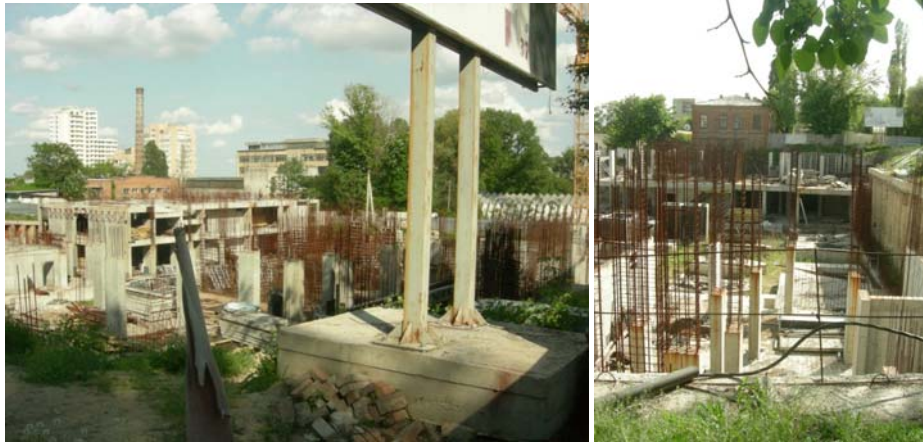
Будівництво житлового будинку по вул. Фурманова, 11 у м. Дніпропетровськ, на кінець 2010 року
