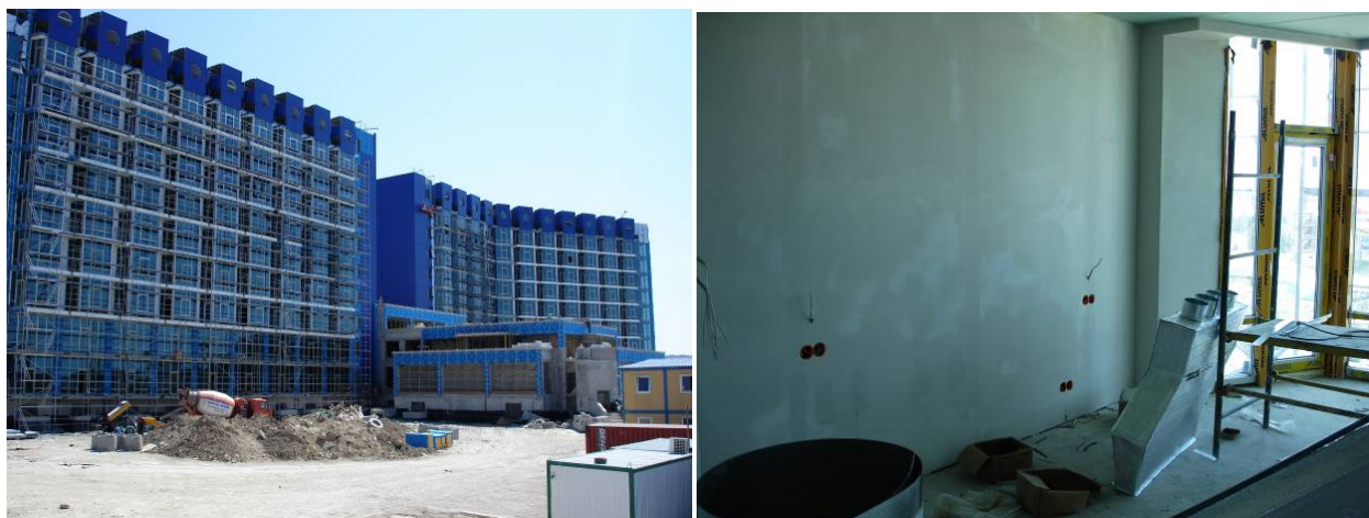
Хід робіт на об'єкті будівництва у парку Перемоги в м. Севастополі станом на 27.04.2009 р.
