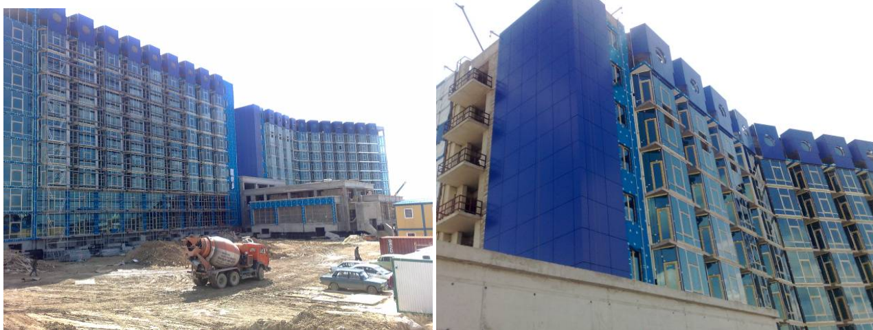
Хід робіт на об'єкті будівництва у парку Перемоги в м. Севастополі станом на 20.03.2008 р.
