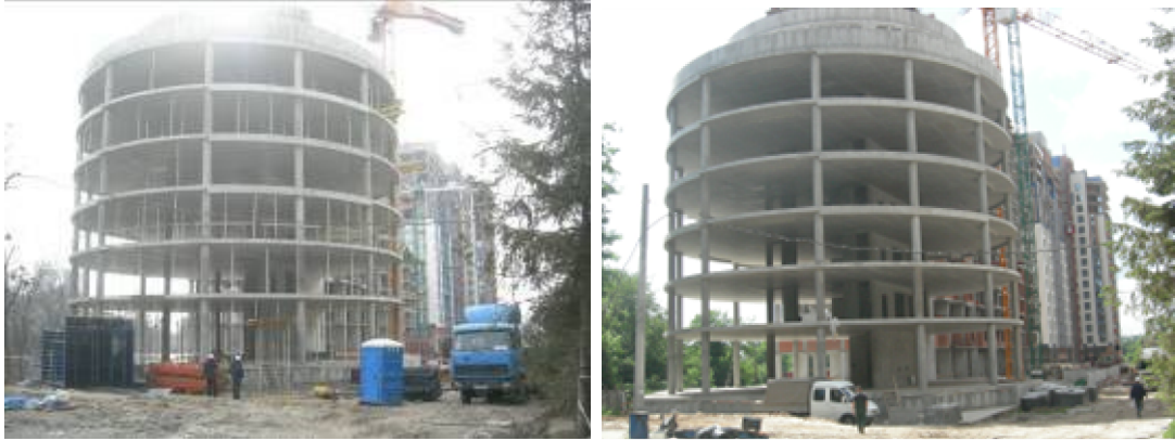
Хід робіт з будівництва ж/б 1 по вул. Професора Підвисоцького у Печерському районі м. Києва станом (зліва-направо): на 12.03.2009 р. та на 18.06.2009 р.
