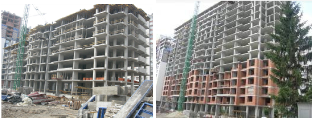
Хід робіт з будівництва ж/б 4 по вул. Професора Підвисоцького у Печерському районі м. Києва станом (зліва-направо): на 12.03.2009 р. та на 18.06.2009 р.
