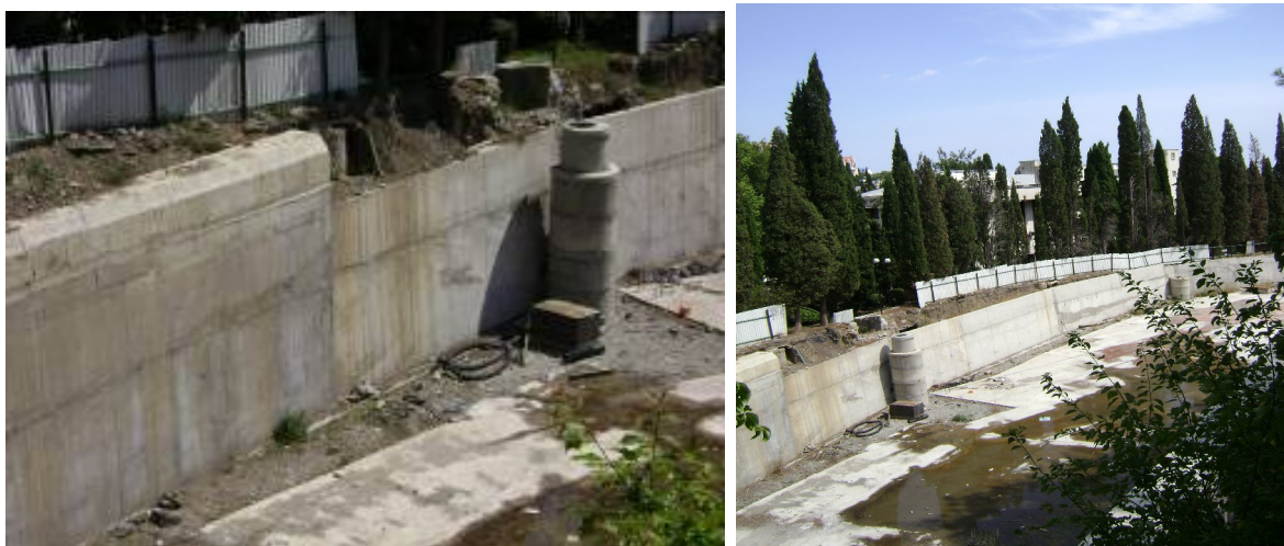
Стан будівництва за проектом реконструкції кінотеатру з добудовою рекреаційно-оздоровчого корпусу за адресою: АР Крим, смт. Гурзуф, вул. Ленінградська, 1 А станом на початок травня 2010 року та кінець серпня 2010 р.
