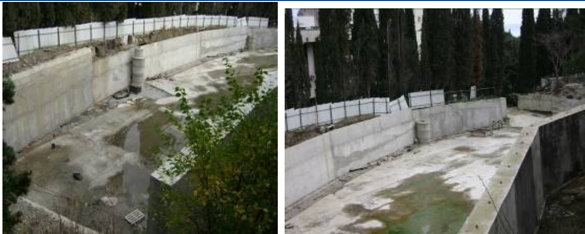
Стан будівництва за проектом реконструкції кінотеатру з добудовою рекреаційно-оздоровчого корпусу за адресою: АР Крим, смт. Гурзуф, вул. Ленінградська, 1 А станом на середину листопада 2009 року та на початок березня 2010 року
