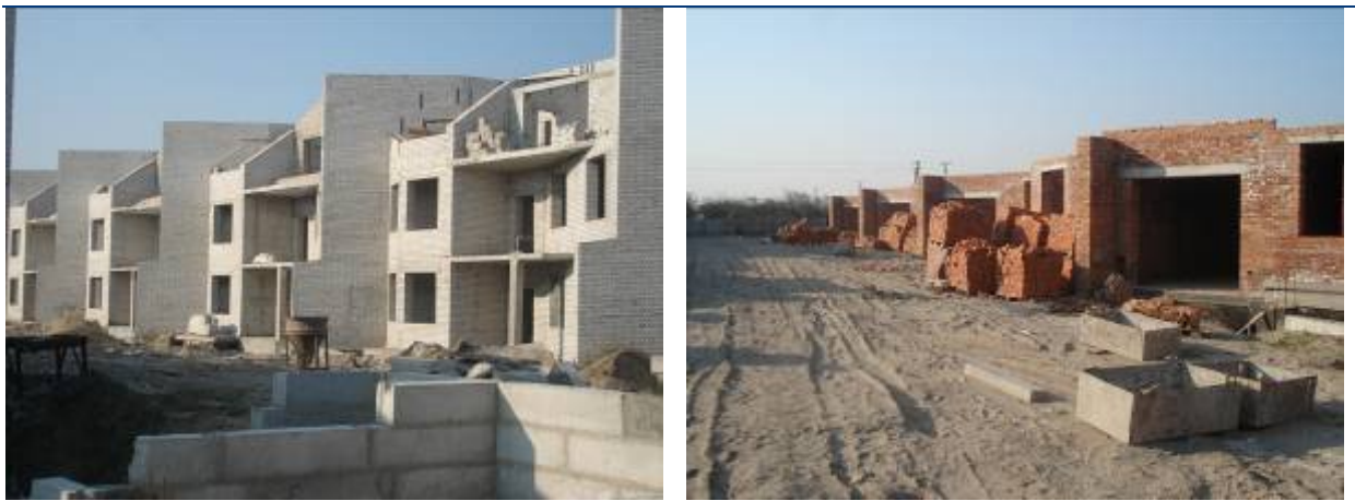
Хід будівництва житлового комплексу з об'єктами соціально-побутової інфраструктури по вул. Леніна, 119 у с. Петропавлівська Борщагівка Києво-Святошинського району Київської області станом на кінець квітня 2009 року
