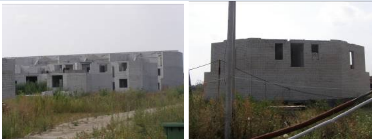
Хід будівництва житлового комплексу з об'єктами соціально-побутової інфраструктури по вул. Леніна, 119 у с. Петропавлівська Борщагівка Києво-Святошинського району Київської області станом на кінець серпня 2009 року
