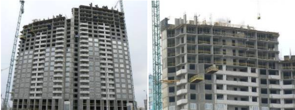
Рисунок 1. Стан будівництва житлового будинку по вул. О. Пчілки у 4-му м/н ж/м Позняки на грудень 2009 р.
