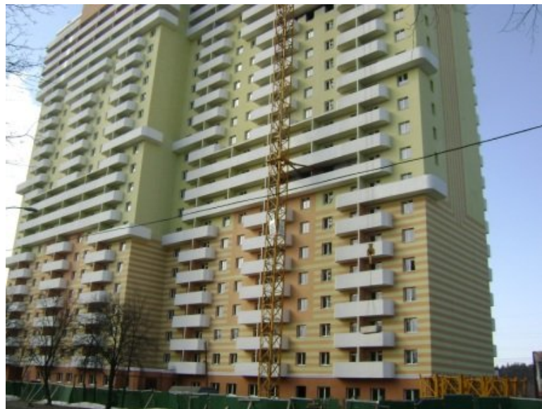
Рисунок 2. Будівельні роботи на об'єкті будівництва в м. Києві по вул. Генерала Наумова, 66
