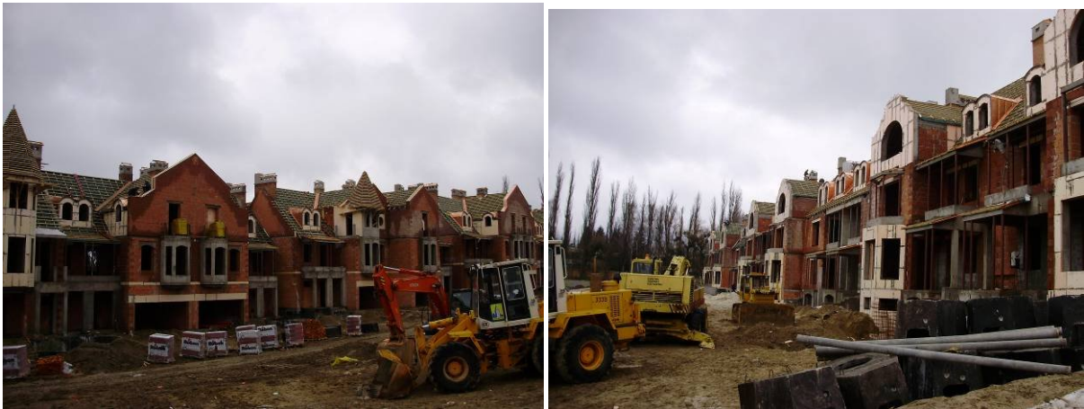
Рисунок 1.1. Будівництво багатофункціонального торговельно-розважального комплексу з сервісними службами та індивідуальною житловою забудовою на вул. Метрологічній, 18 у м. Києві станом на початок квітня 2009 р.
