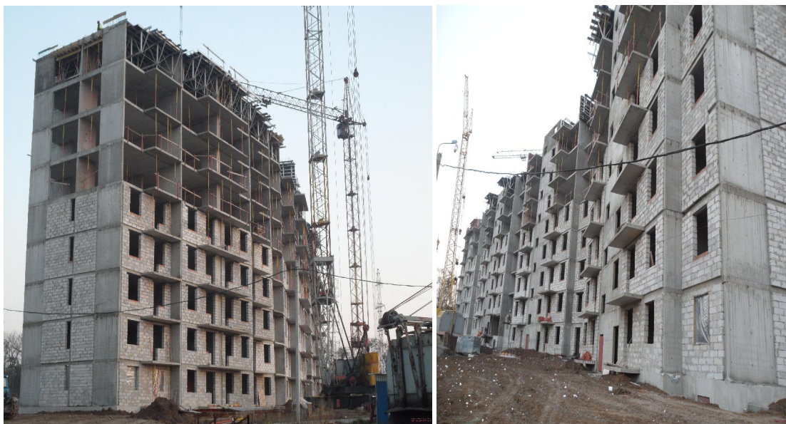
Рисунок Ошибка! Текст указанного стиля в документе отсутствует.. Житловий будинок по вул. Зубарева, 7 у м. Харкові станом на 01.10.2011 р.
