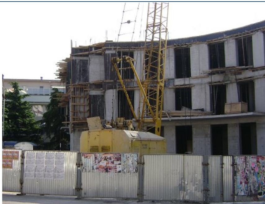
Хід робіт на об'єкті будівництва по вул. Ігнатенко, 9 у м. Ялті станом на 04.06.2009 р.
