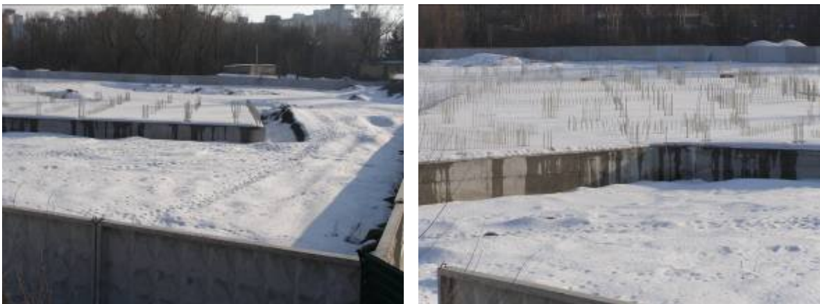
Будівництво готельно-житлового комплексу з приміщеннями соціально-побутового призначення по проспекту Академіка Глушкова, 926 у м. Києві станом на березень 2010 року
