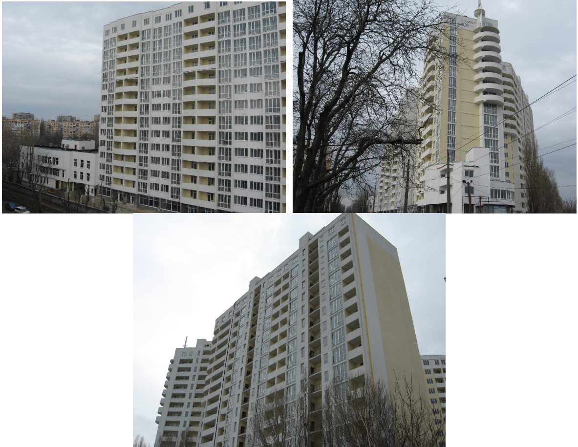
Будівництво житлового будинку по вул. Ак. Корольова, 5/2 у м. Одесі станом на 24.02.2012 р.
