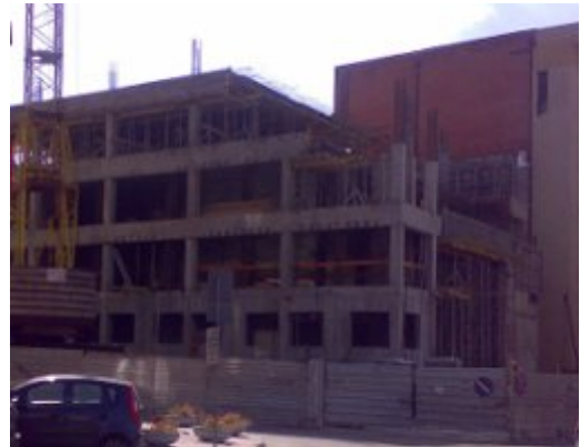
Рисунок 1.10. Будівництво багатофункціонального комплексу по вул. Шевченка, 53, станом на початок червня 2008 року
