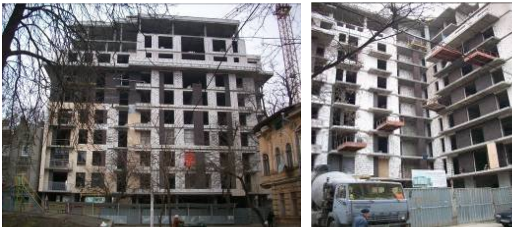
Будівництво житлового будинку по вул. Відрадній, 13 станом на початок березня 2010 року
