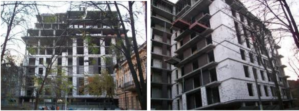
Будівництво житлового будинку по вул. Відрадній, 13 станом на кінець листопада 2009 року
