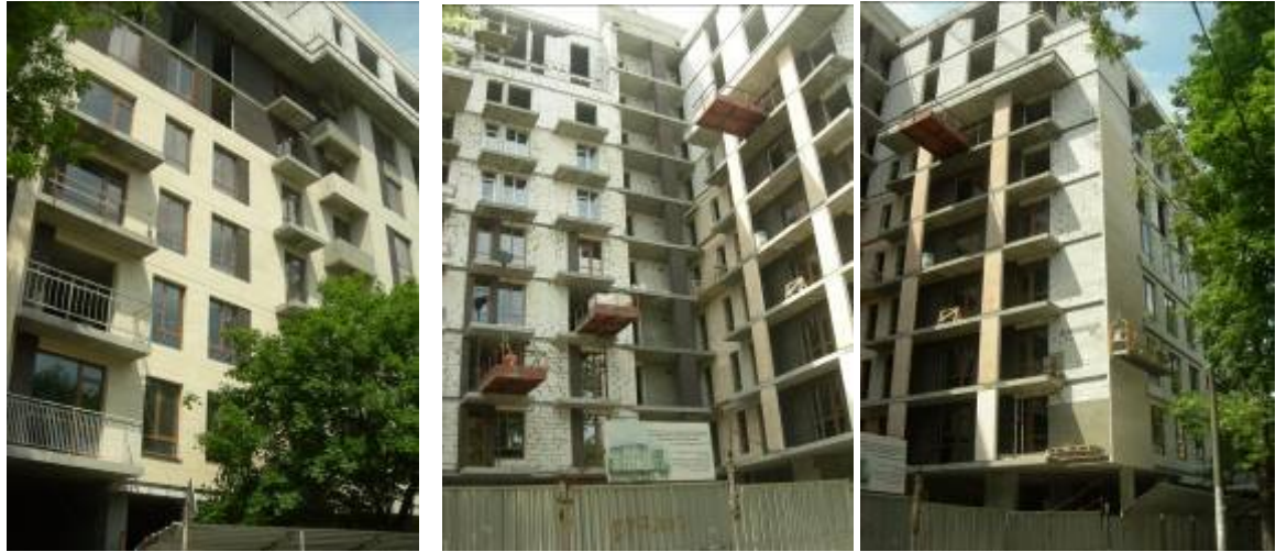
Будівництво житлового будинку по вул. Відрадній, 13 станом на кінець травня 2010 року
