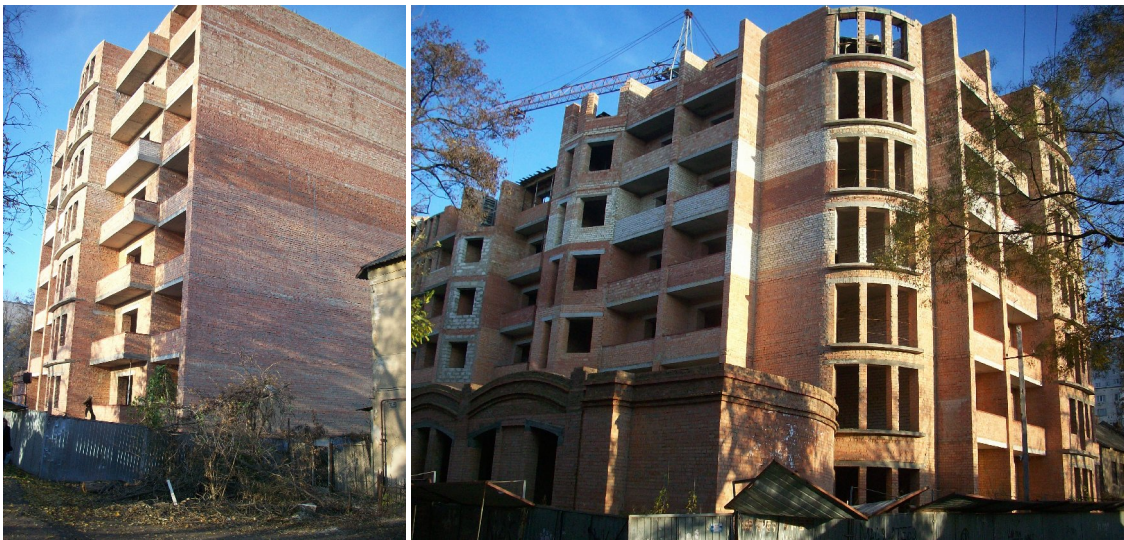
Будівництво житлового будинку по пров. Черепанових, 12. станом на 26.11.2009 р
