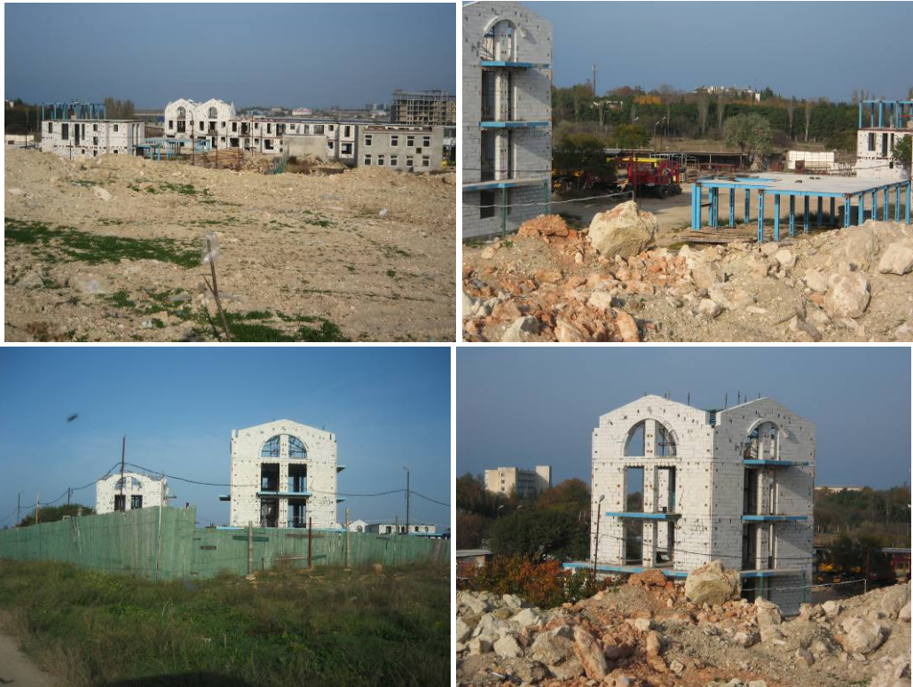
Будівельні роботи із зведення пансіонату котеджного типу в бухті «Омега» у м. Севастополі на кінець 2008 року
