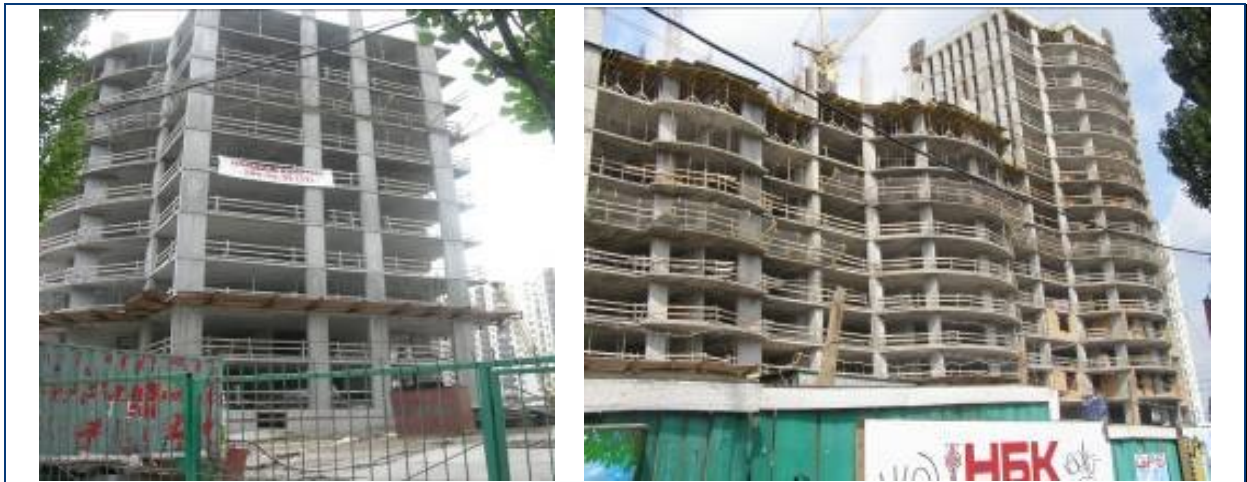
Будівельні роботи на секціях 1-3 житлового будинку № 26 станом на середину травня 2009 року
