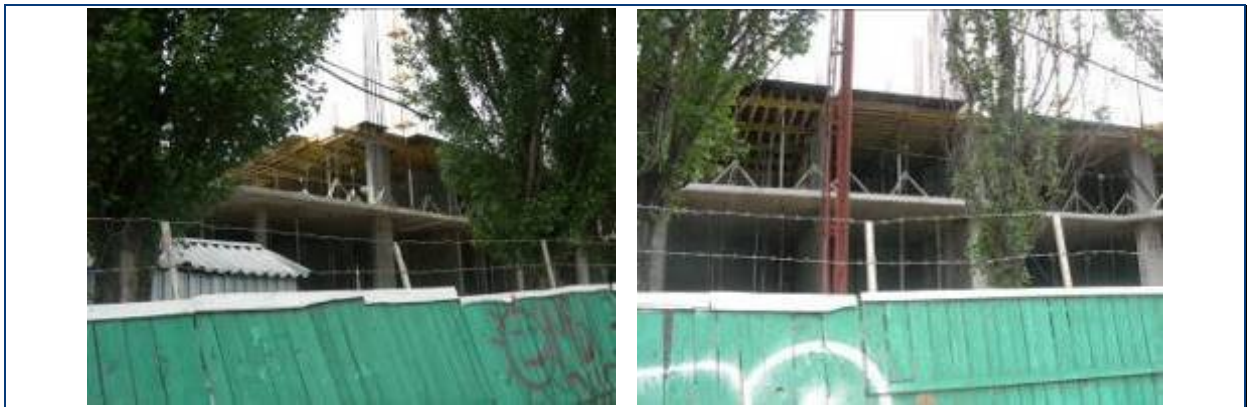
Будівельні роботи на секціях 1-4 житлового будинку № 28 станом на середину травня 2009 року
