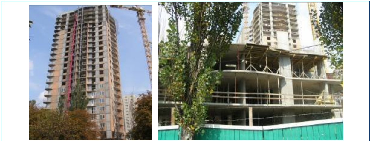
Будівельні роботи по житловим будинкам №№ 33 та 34 та № 35 станом на кінець серпня 2009 року
