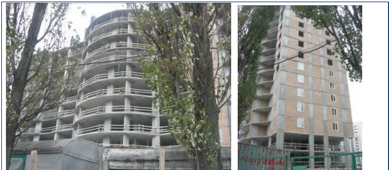
Будівельні роботи на секціях 1-3 житлового будинку № 26 станом на початок листопада 2009 року
