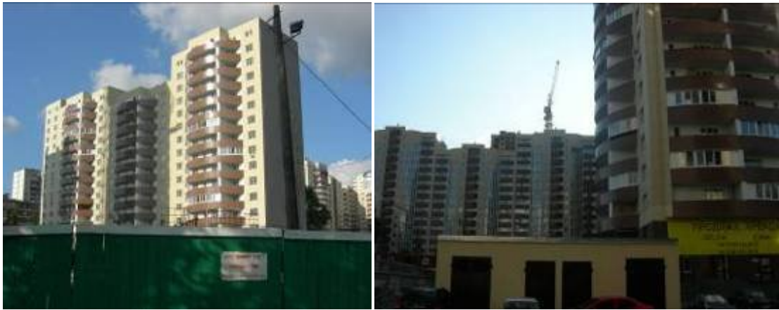
Секції 5-11 житлового будинку № 28
