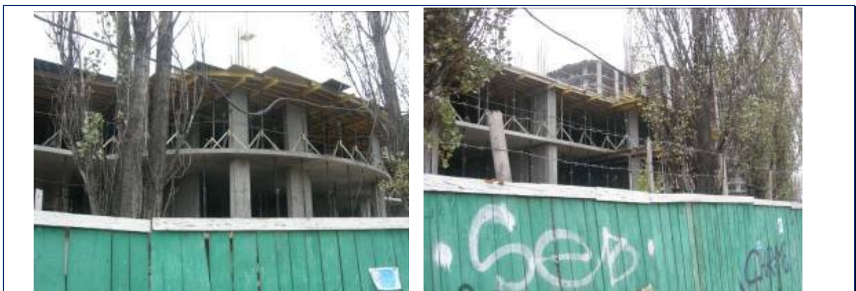
Будівельні роботи на секціях 1-4 житлового будинку № 28 станом на початок листопада 2009 року
