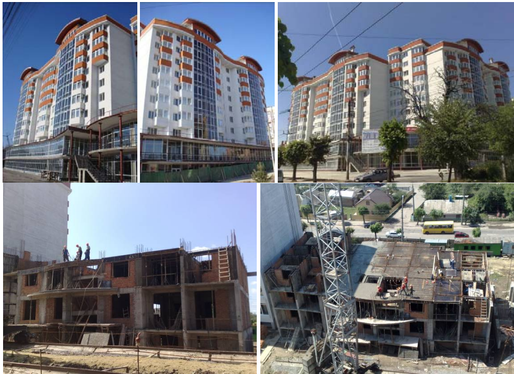
Будівництво житлового комплексу у м. Чернівцях по вул. Руській, 219 (будинки №№ 5 та 6 -зверху, будинок №4 - знизу) станом на середину травня 2009 року
