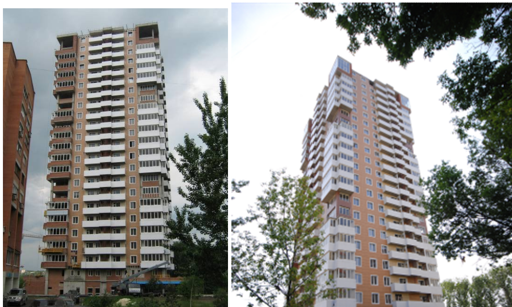
Житловий будинок №1 по пр. Панфілова у м. Донецьку станом на 29.05.2009 р. та станом на вересень 2009 р.
