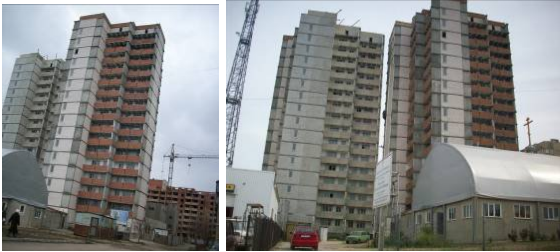
Житлові будинки № 1 та № 1А у мікрорайоні III-4-1 Котовського у м. Одесі станом на 20.02.2009 р. та станом на 29.05.2009 р.
