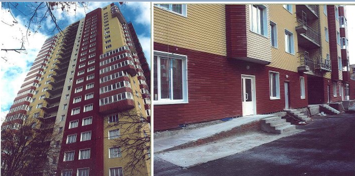
Хід робіт на об'єкті будівництва по вул. 23 Серпня (в районі буд. 31) у м. Харкові станом на кінець жовтня 2010 року
