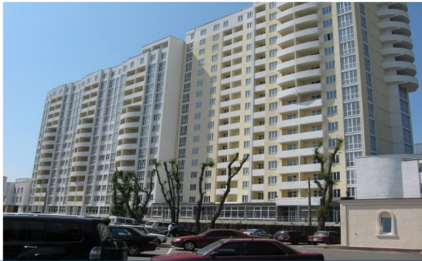
Рисунок 1.3. Хід будівництва житлового будинку по вул. Ак. Корольова, 5/2 у м. Одесі станом на 12.06.2012 р.
