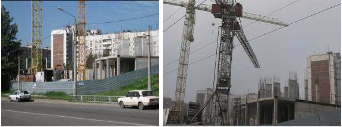
Об'єкт незавершеного будівництва по вул. Шевченка (район вул. Саперної) у м. Харкові станом на кінець липня 2010 року та початок лютого 2013 року (зліва направо)
