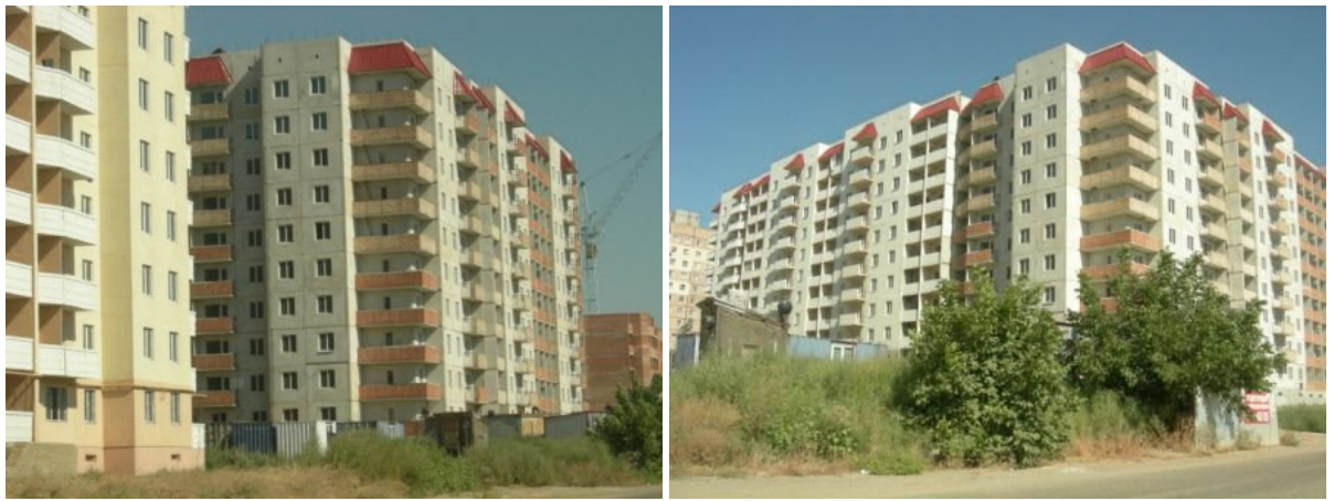
Рисунок 6. Стан будівельної готовності житлового будинку № 19 та №20 у мікрорайоні III-4-3 Котовського у м. Одесі станом на 27.08.2010 р.
