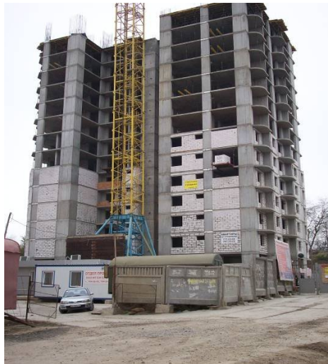
Рисунок 3. Стан будівельної готовності житлового будинку № 36 у мікрорайоні «Д» Південний у м. Одесі
