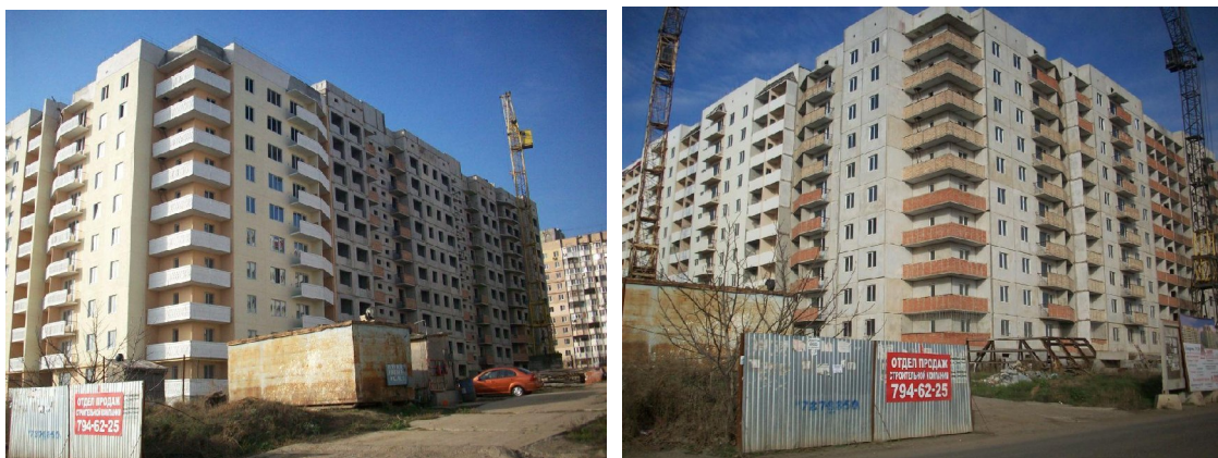
Рисунок 6. Стан будівельної готовності житлового будинку №19 та №20 у мікрорайоні III-4-3 Котовського у м. Одесі станом на 30.11.2009 р.
