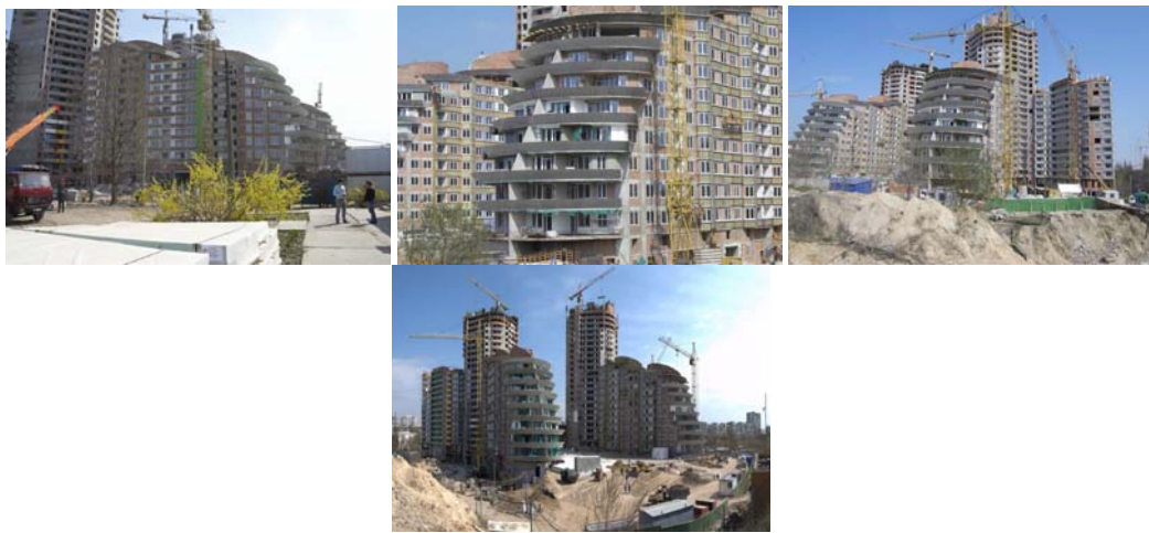
Ступінь виконання будівельних робіт житлового комплексу «Крістова гірка» (I черга) по вул. Вишгородській, 45 у м. Києві (зверху зліва-направо секції 4.2, 3.3, 1.3, 2.2, 1.3 та секції 4.1, 3.2, 1.2, 2.1, знизу зліва-направо загальний вигляд будівництва I черги) станом на початок травня 2009 року
