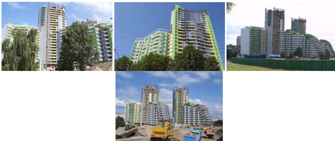
Ступінь виконання будівельних робіт житлового комплексу «Крістова гірка» (I черга) по вул. Вишгородській, 45 у м. Києві (зверху зліва-направо секції 4.2, 3.3, 1.3, 2.2, 1.3 та секції 4.1, 3.2, 1.2, 2.1, знизу зліва-направо загальний вигляд будівництва I черги) станом на кінець червня 2009 року
