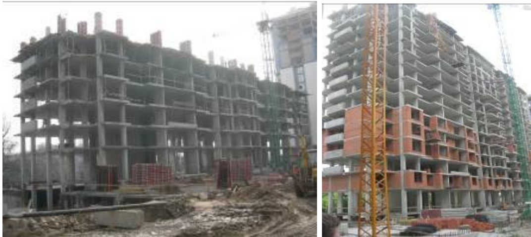
Рисунок 1.2. Хід робіт з будівництва ж/б 2 по вул. Професора Підвисоцького у Печерському районі м. Києва станом (зліва-направо): на 12.03.2009 р. та на 18.06.2009 р.
