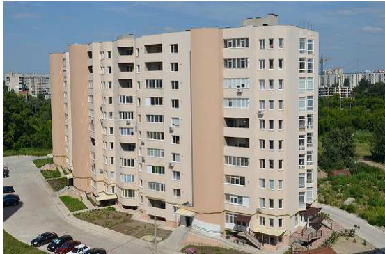
Житловий будинок у м. Сумах по вул. Харківській, 3/2
