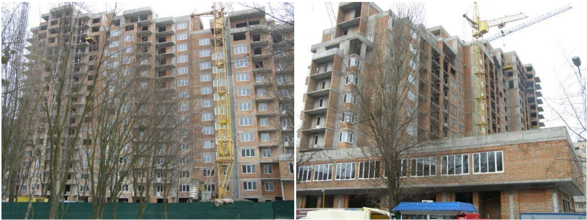
Будівництво житлового будинку по вул. Жовтневій, 31а станом на 17.02.2009 р.
