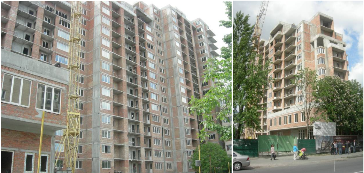
Будівництво житлового будинку по вул. Жовтневій, 31а станом на 18.05.2009 р.
