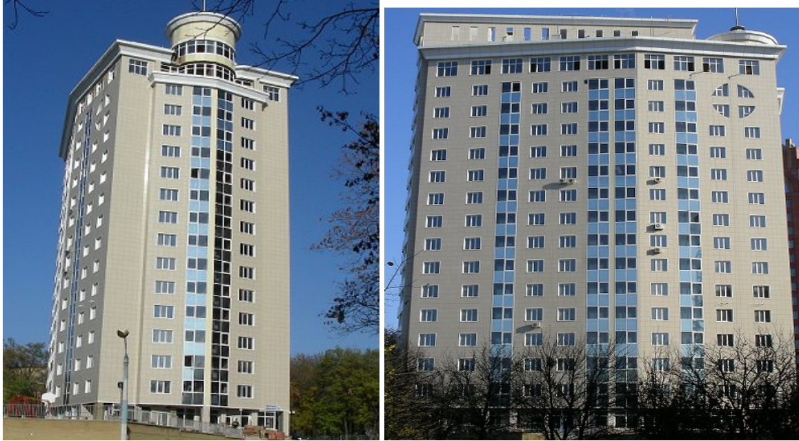
Об'єкт будівництва по пр. Панфілова
