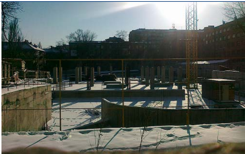
Хід робіт з будівництва багатоповерхового житлового будинку з вбудовано-прибудованими приміщеннями громадського призначення та підземного паркінгу по вул. Білоруській, 36-а у Шевченківському районі м. Києва станом на 01.03.2011 р.
