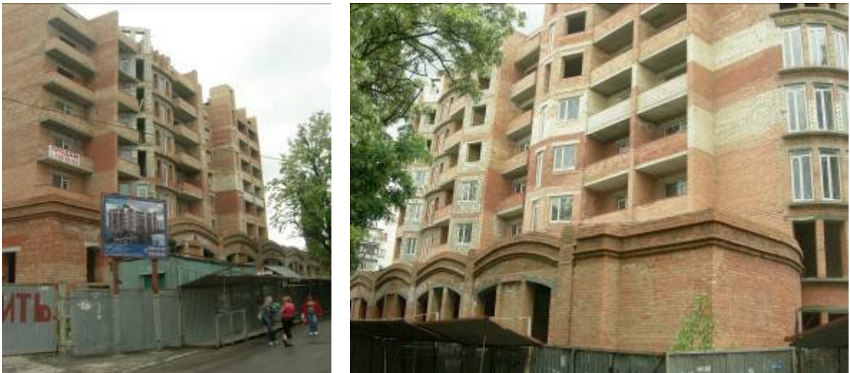
Будівництво житлового будинку по пров. Черепанових, 12. станом на травень 2010 р.
