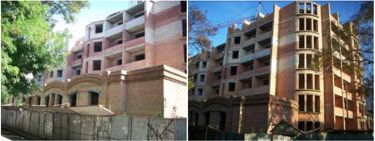
Будівництво житлового будинку по пров. Черепанових, 12. станом на 08.09.2009 р. та станом на 26.11.2009 р.
