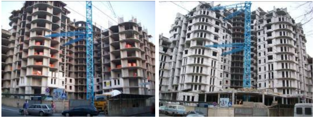
Будівельні роботи на об'єкті будівництва офісно-житлового комплексу по вул. Канатній, 27 станом на 22.08.2008 р. та на середину лютого 2009 р.
