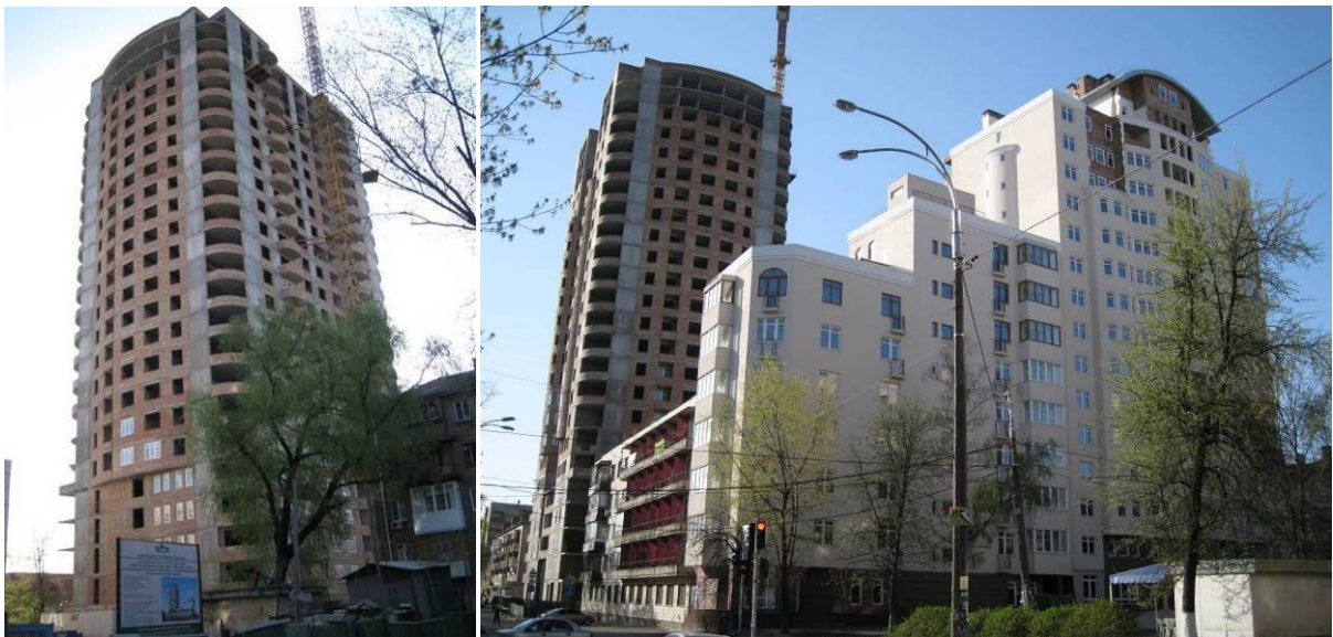
Стан будівництва житлових будинків №№ 1, 2, 4 по вул. М. Кривоноса та Климента на 21.04.2009 р.
