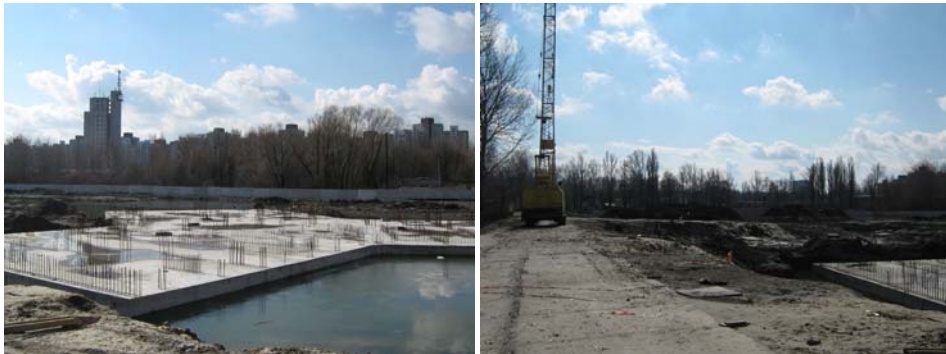
Будівництво готельно-житлового комплексу з приміщеннями соціально-побутового призначення по проспекту Академіка Глушкова, 926 у м. Києві станом на кінець березня 2009 року
