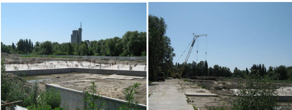
Будівництво готельно-житлового комплексу з приміщеннями соціально-побутового призначення по проспекту Академіка Глушкова, 926 у м. Києві станом на початок червня 2009 року
