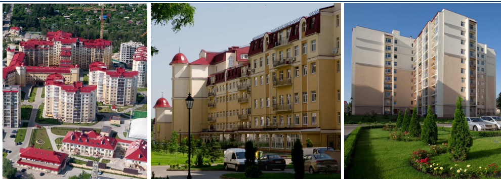
Житловий комплекс «Чайка» по вул. Лобановського, 1 у с. Чайці Києво-Святошинського району Київської області (I черга)
