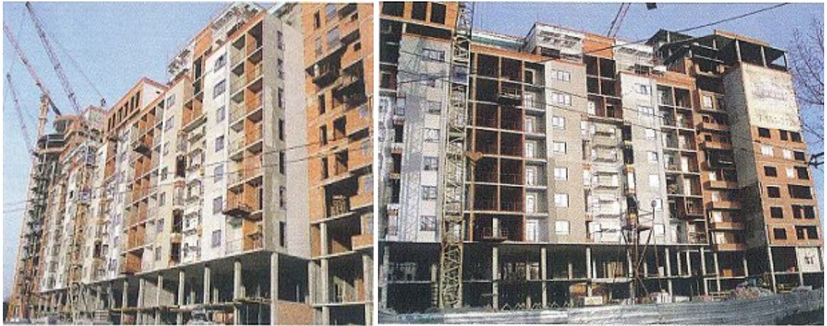
Рисунок 1.2. Хід робіт на об'єкті будівництва по пров. Банному в м. Харкові станом на 01.01.2009 р.
