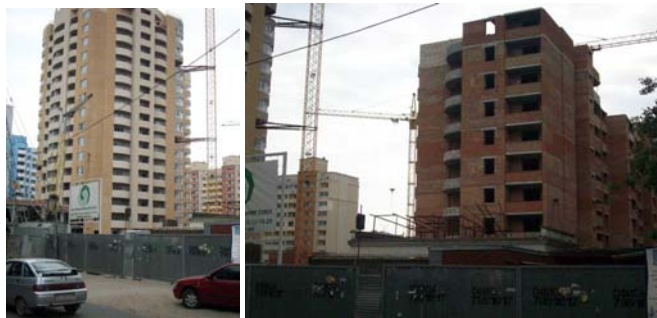
Стан будівництва громадсько-житлового комплексу по вул. М. Говорова, 10 А у м. Одесі на кінець травня 2009 року
