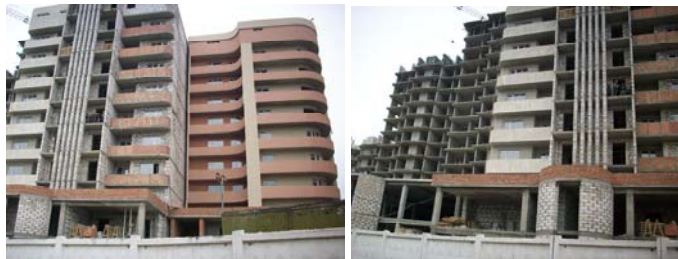
Стан будівництва громадсько-житлового комплексу у мікрорайоні ім. Таїрова на розі вул. 25-ї Чапаївської дивізії та просп. Маршала Жукова у м. Одесі на кінець травня 2009 року
