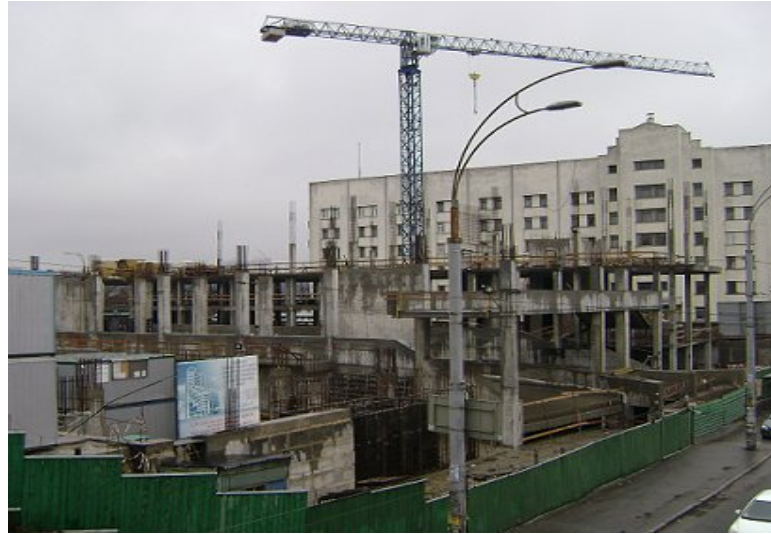
Стан будівництва офісної будівлі за адресою: м. Київ, пров. Індустріальний ,1-А на 15.03.2009 р.
