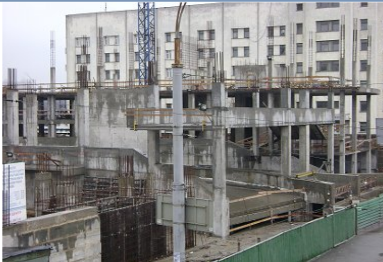
Стан будівництва офісної будівлі за адресою: м. Київ, пров. Індустріальний ,1-А на 05.06.2009 р.
