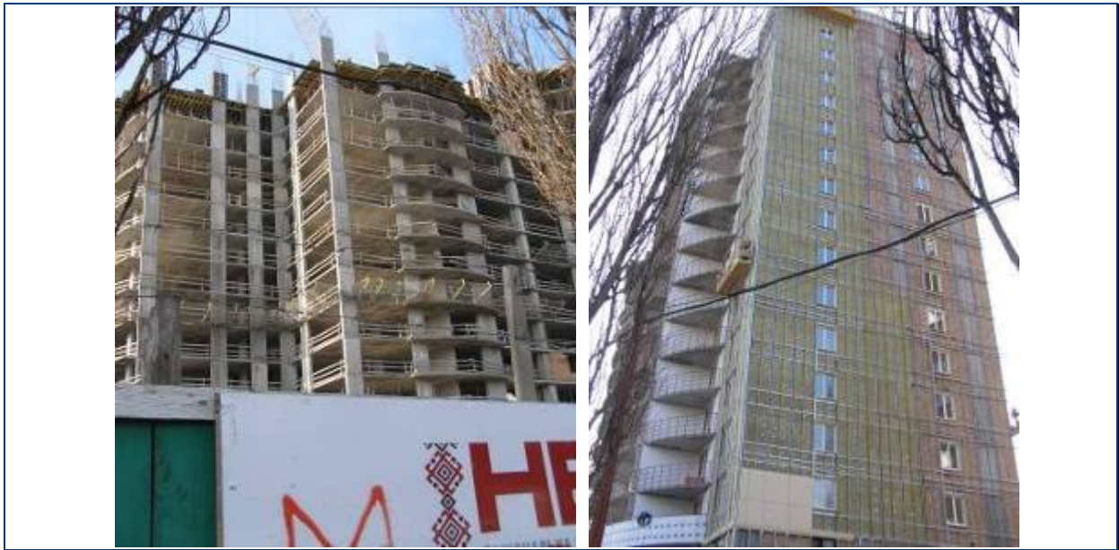
Будівельні роботи на секціях 1-3 житлового будинку № 26 станом на кінець березня 2010 року
