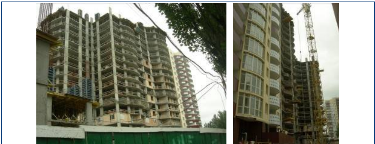
Будівельні роботи на секціях 1-3 житлового будинку № 26 станом на кінець травня 2010 року
