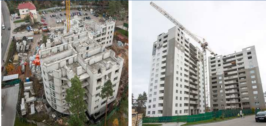
Будівництво житлового комплексу (II черга) по вул. Лобановського, 1 у с. Чайці Києво-Святошинського району Київської області станом на початок жовтня 2012 року (зліва на право: будинок №8, будинок №9)
