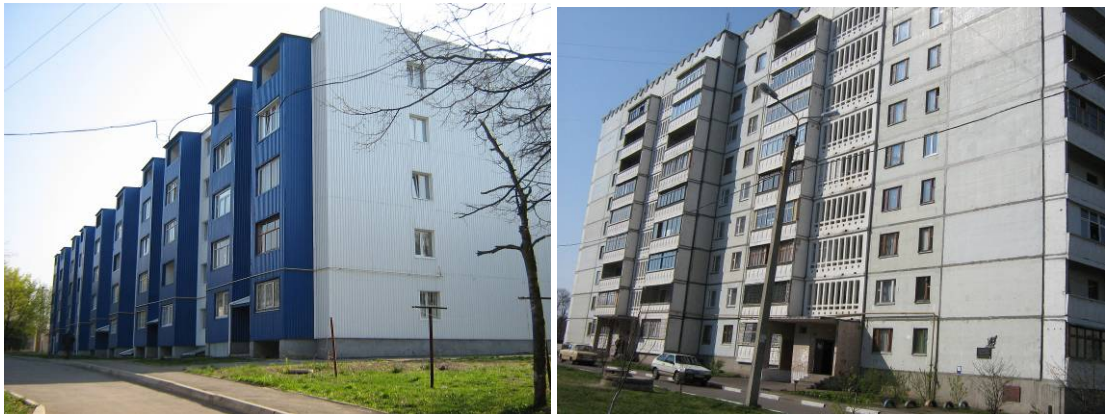
Реконструйований гуртожиток по вул. 17 Партз'їзду, 24 та житловий будинок по вул. Зубарєва, 32 у м. Харкові (зліва-направо)
