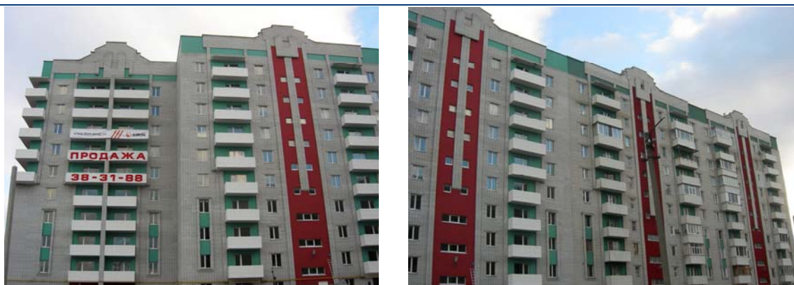
Рисунок 2.5. Стан об'єкта будівництва по вул. Сумгайтській, 19/1 у м. Черкасах на 29.01.2008 р.
