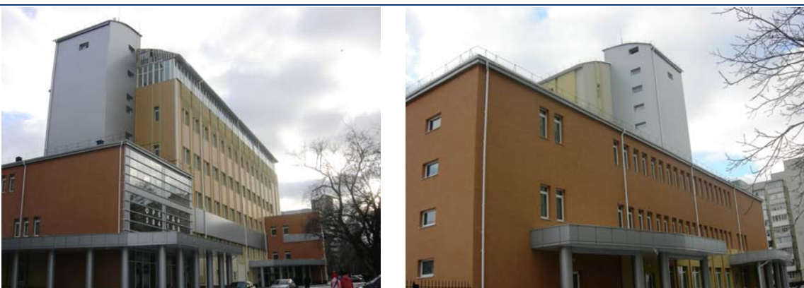
Рисунок 2.6. Стан об'єкта будівництва по вул. Паризької Комуни, 7 у м. Черкасах на 29.01.2008 р.
