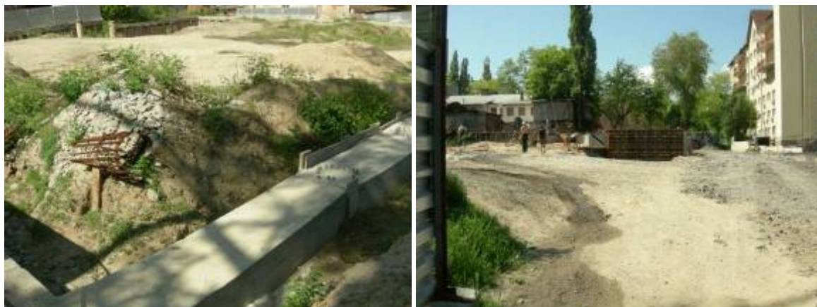
Хід робіт на об'єкті будівництва по вул. Шевченка у м. Дніпропетровську в 2010 році
