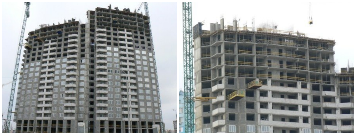
Рисунок 2. Стан будівництва житлового будинку по вул. О. Пчілки у 4-му м/н ж/м Позняки на грудень 2009 р.
