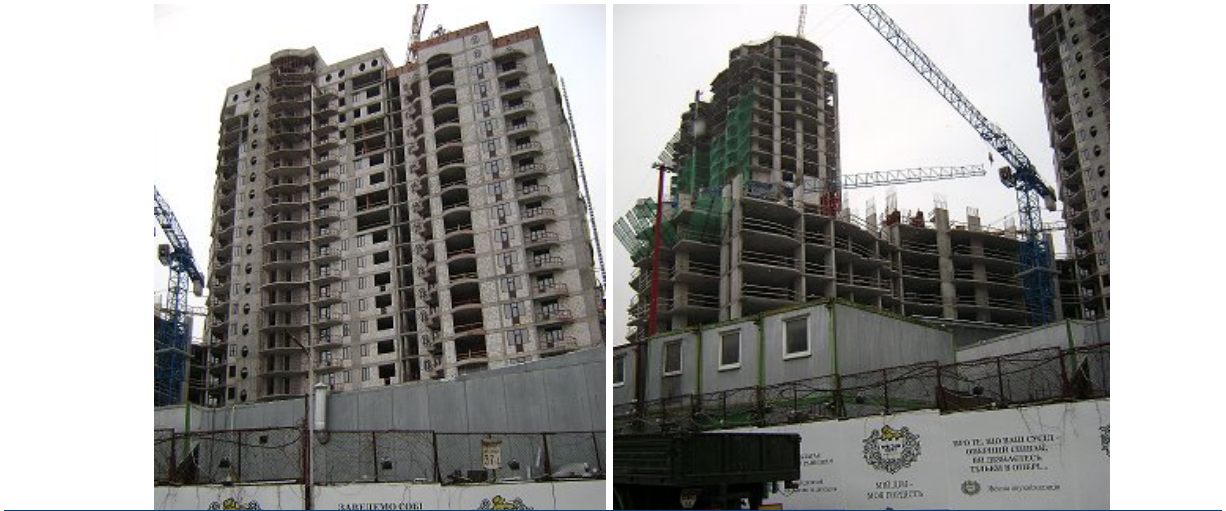
Будівництво житлово-офісного комплексу з вбудованими, прибудованими приміщеннями та підземним паркінгом по вул. Анрі Барбюса, 37/1 у Печерському районі м. Києва станом на 15.12.2009 р.
