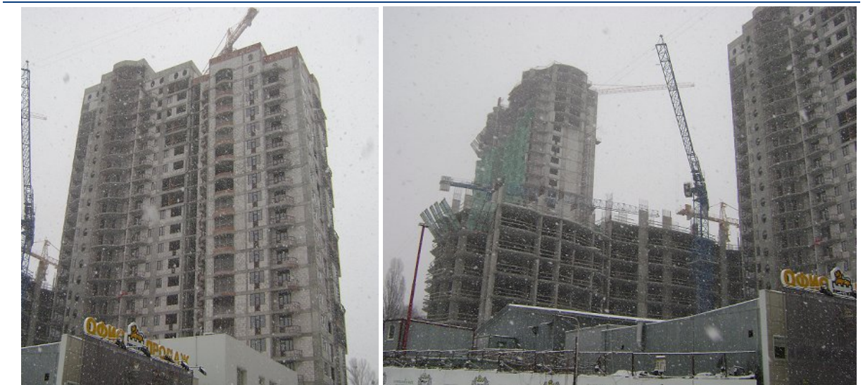
Будівництво житлово-офісного комплексу з вбудованими, прибудованими приміщеннями та підземним паркінгом по вул. Анрі Барбюса, 37/1 у Печерському районі м. Києва станом на 15.03.2010 р.
