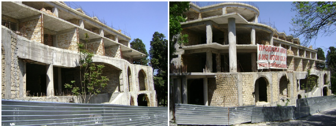
Рисунок 2. Стан будівництва рекреаційного комплексу по вул. Дворцове шосе, 3 у м. Алуці станом на 06.05.2010 р.
