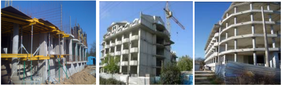
Фото будівництва Малеого готелю по вул. Франка, 11 у м. Євпаторії станом (зліва-направо): на 23.04.2008 р., на 18.08.2008 р. та на 08.12.2008 р. відповідно
