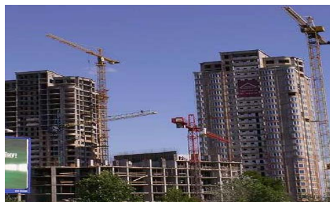
будівництво комплексу «Південна Брама», червень 2006 року
