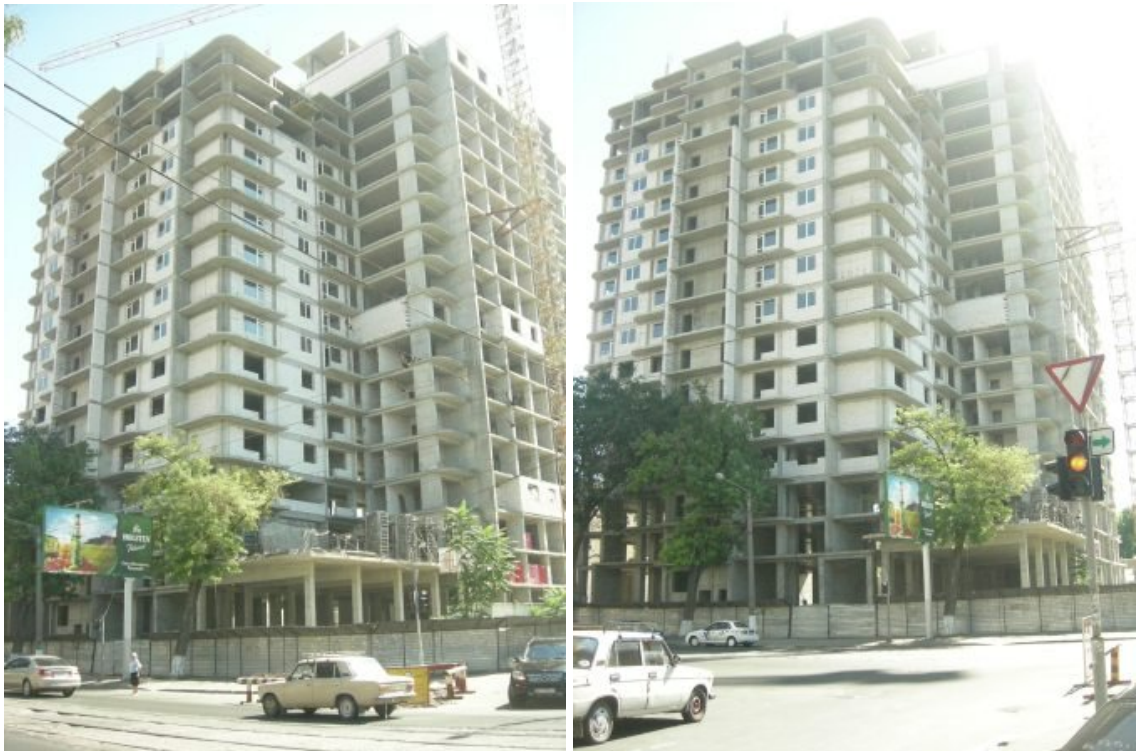
Рисунок 2. Стан будівництва житлового будинку по вул. Прохорівській, 39-41 у м. Одесі, на вересень 2010 р.
